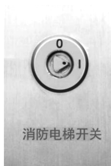
图 D.1 消防电梯开关样式
